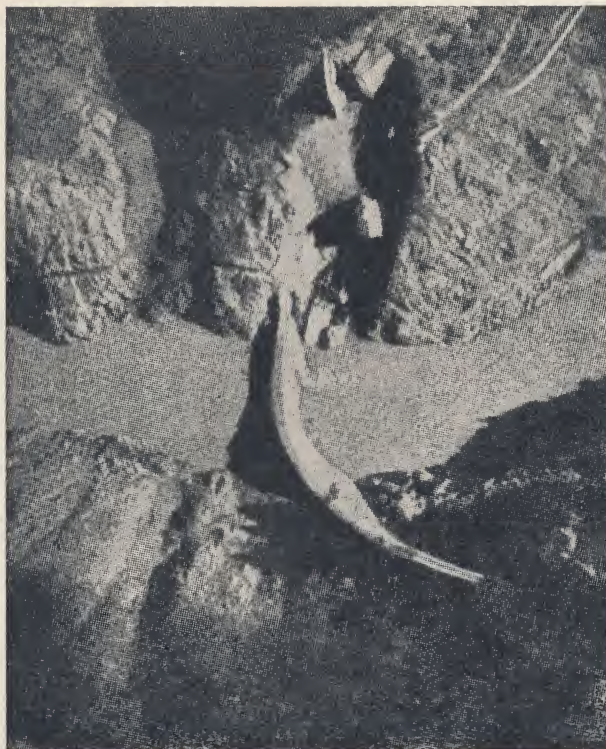
Sl. 3: Brana Malpasset nakon rušenja
